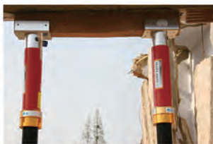
用手动撑杆、梁支撑头和木料来稳固窗户
