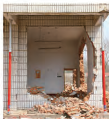
建筑物加固支撑
